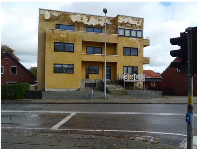
En anden velkomst til Varde – facaderenovering
